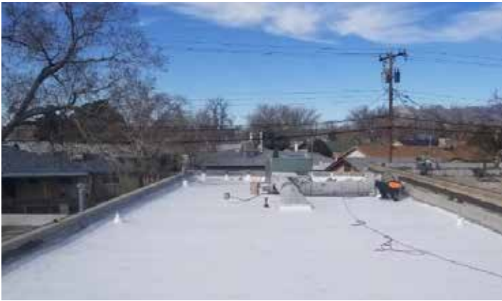
지붕 전체 방수공사를 마친 후의 사진
